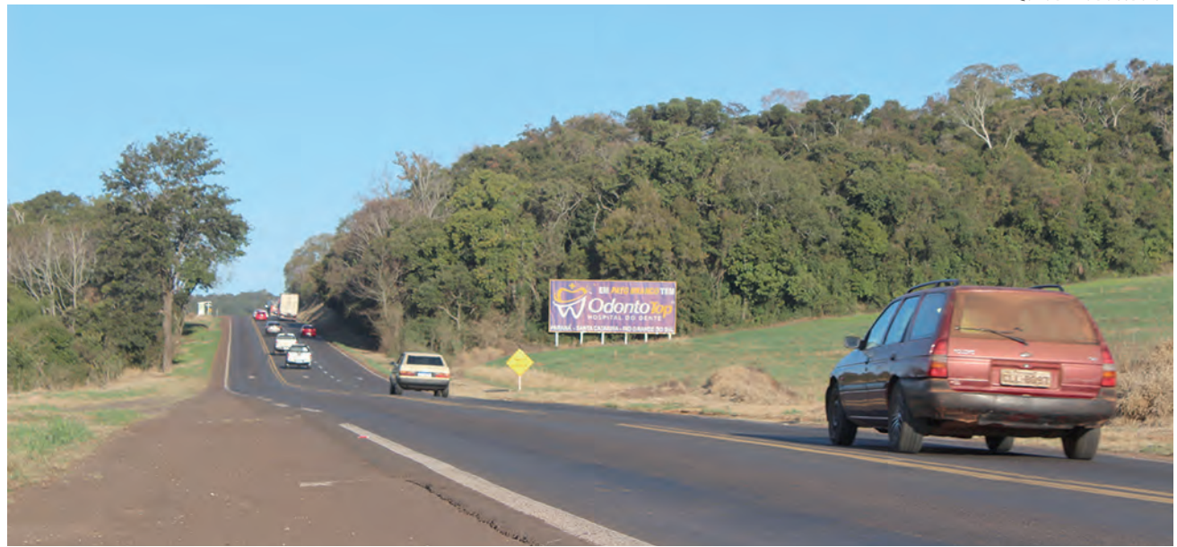
No Banco de Projetos está disponível o estudo da PR-280 e as obras que devem ser executadas
