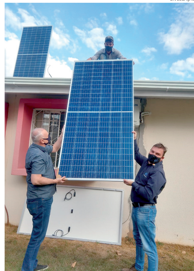
O trabalho de instalação dos painéis fotovoltaicos foi finalizado na última sexta-feira (24)
