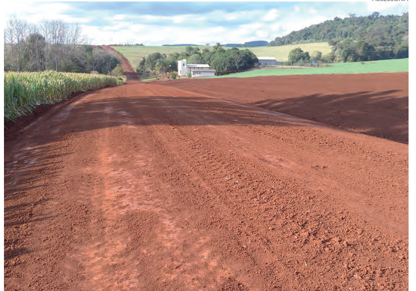
O trecho contemplado será de 2.600 metros
