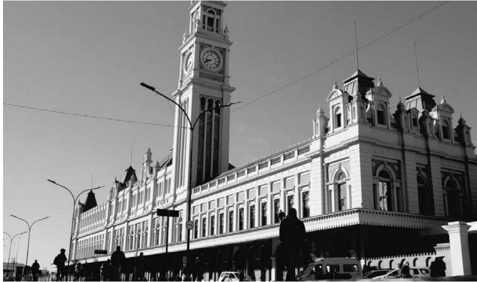
Foram investidos cerca de R$ 85 milhões nas obras de reconstrução
