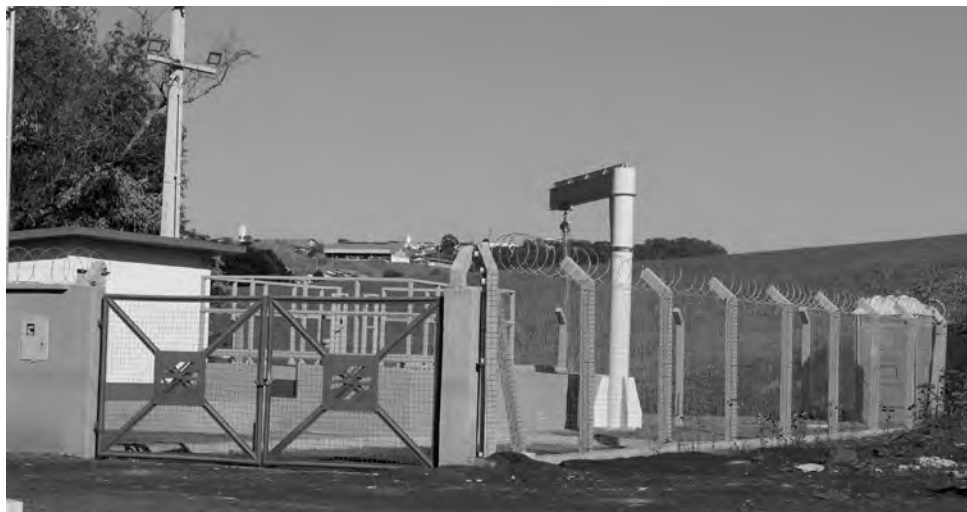
Etapa contemplou a realização de redes coletoras, interceptoras e duas estações elevatórias
