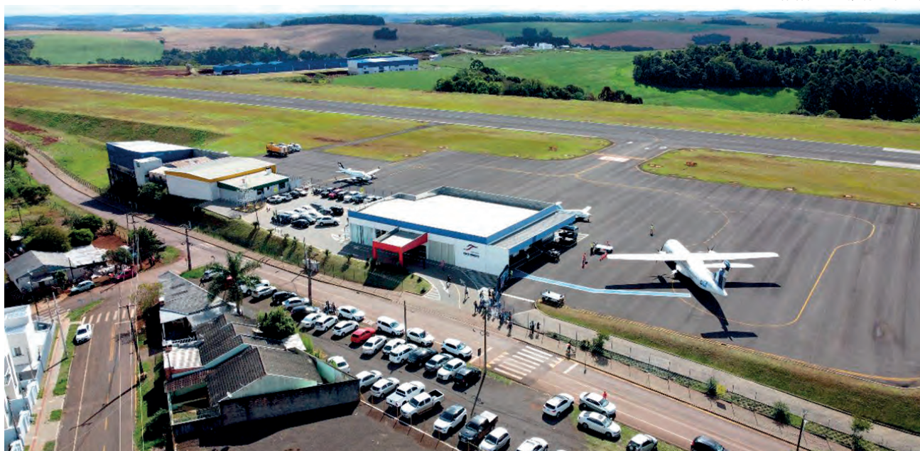
Instalação do PAPI faz parte do projeto de Ampliação do Aeroporto Regional de Pato Branco
