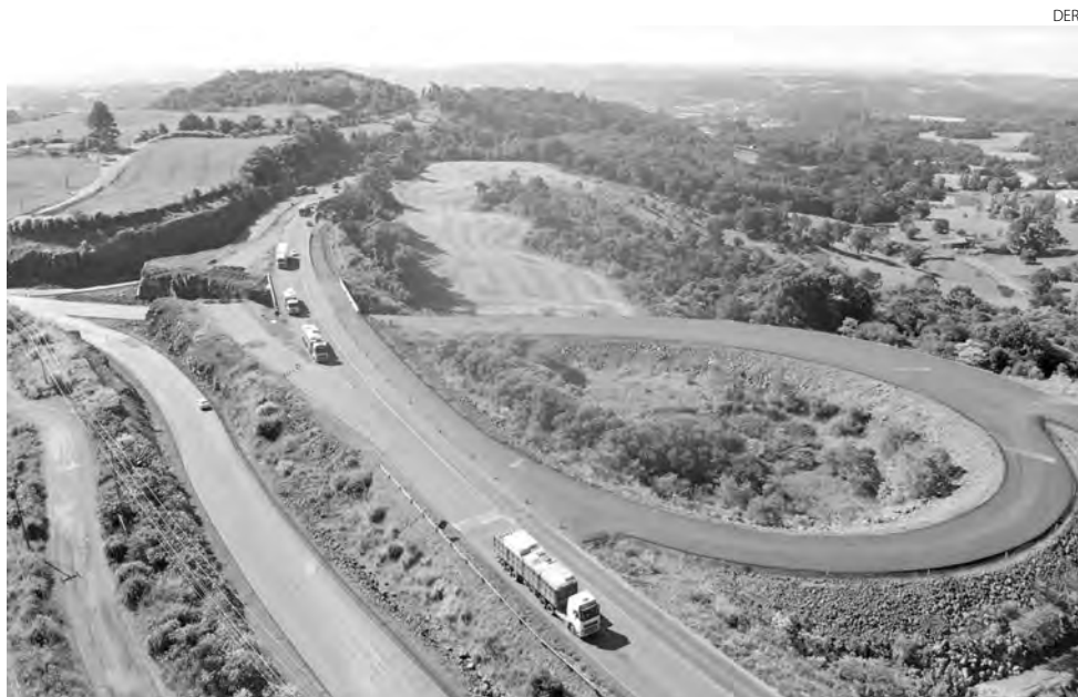
O investimento do Governo do Estado na obra é de R$ 35.318.825,14
