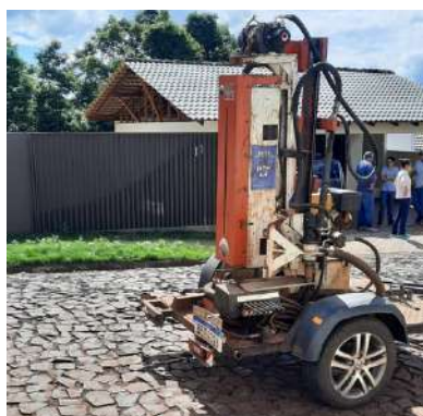
FIGURA 17 –Figura mostrando equipamento automatizado de SPT.
