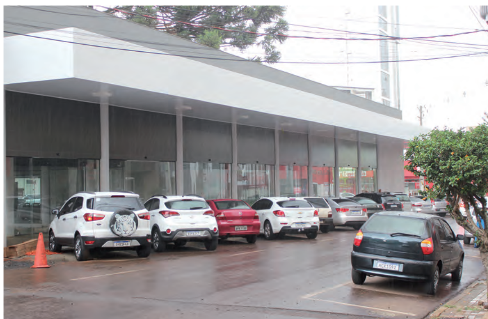
Obra do entorno do terminal, foi paralisada com 7,18% de execução
