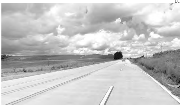
Serão restaurados 45 quilômetros entre Palmas e Clevelândia
