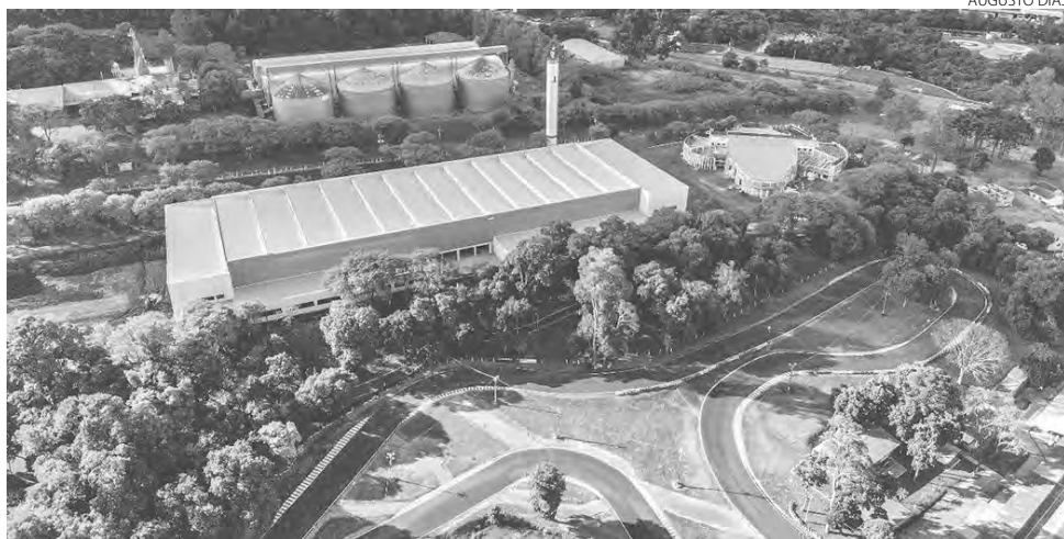
Enquanto isso, os trabalhos para a conclusão das obras do Parque de Exposições seguem
