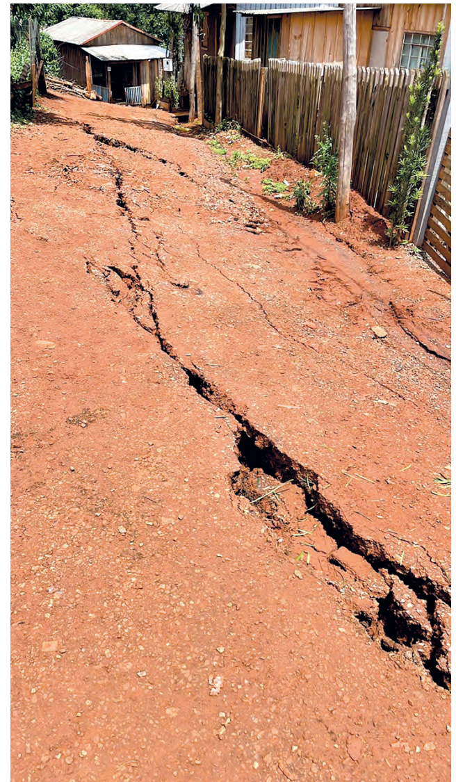
No bairro São Francisco em Francisco Beltrão um morro está desabando
