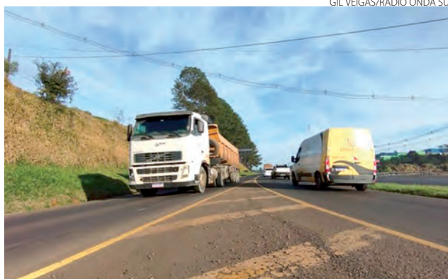
A rodovia PR-483, uma das vias do lote A, é um dos corredores que retira o fluxo de veículos pesados em Francisco Beltrão
