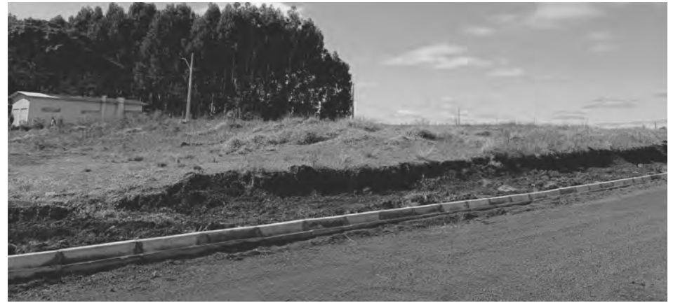
Terreno onde será construído o novo fórum. Pedra fundamental será lançada em agosto
