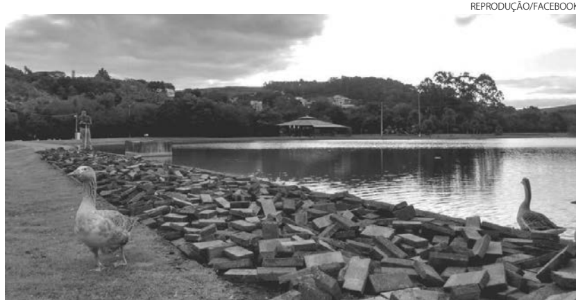
Previsão de conclusão da obra é de 120 dias
