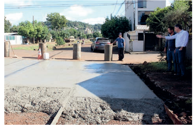
Prefeito acompanha o início da pavimentação de ruas com concreto
