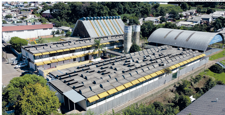
A primeira etapa da reforma compreende retirada de parte da estrutura metálica do ginásio
