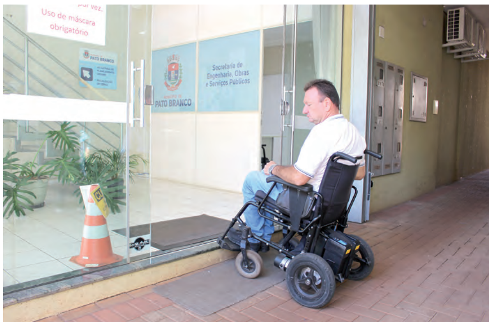
Maioria dos acessos estão inadequados, como na Secretaria de Engenharia e Obras
