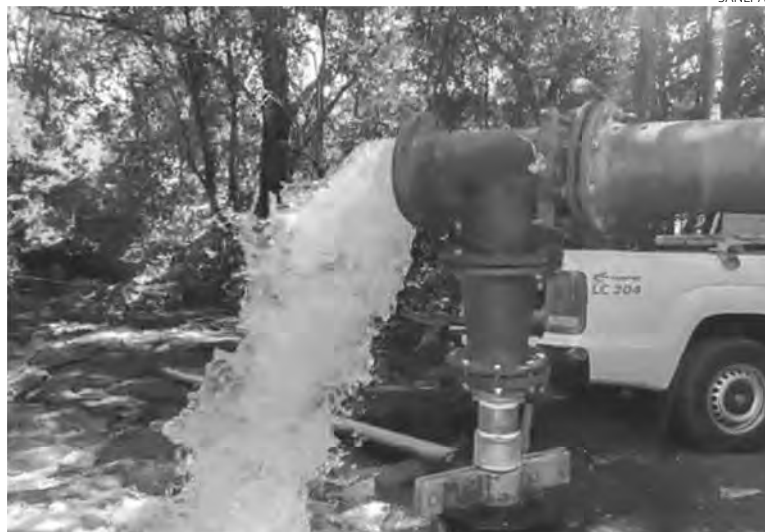
Com a finalização das obras do poço, a suspensão do rodízio vale até segunda
