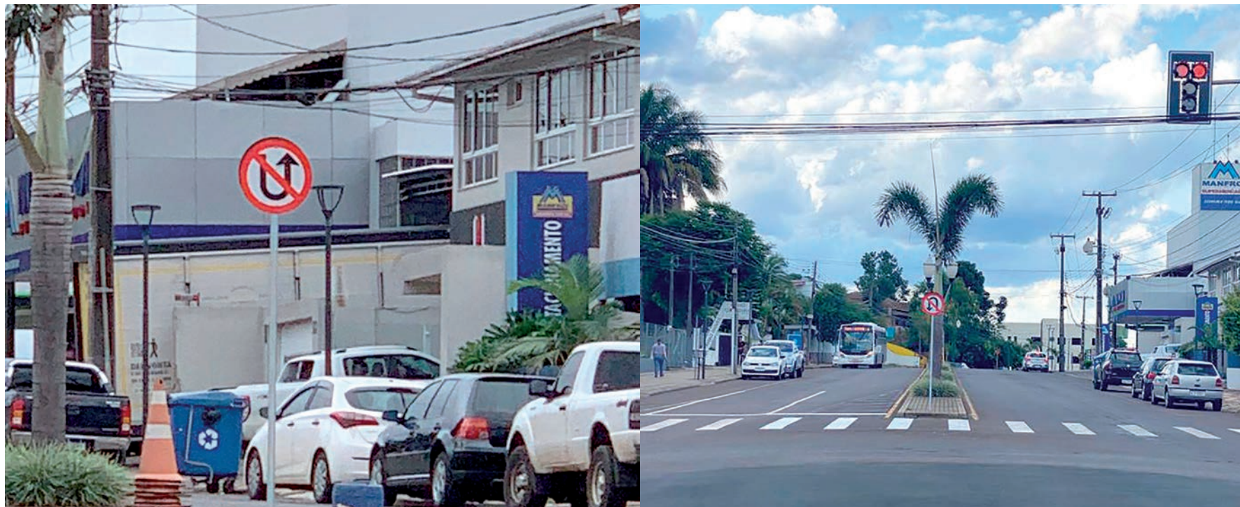
Nessa segunda-feira (31) entrou em funcionamento o novo semáforo da avenida Tupi. Pela manhã, leitores do Diário do Sudoeste observaram uma placa instalada de forma errônea. Já no final da tarde de ontem, a sinalização estava correta.
