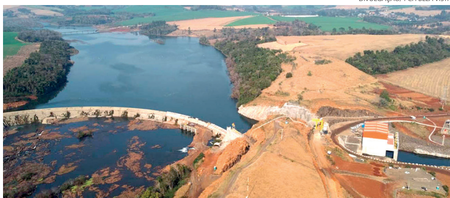
A usina é composta por três unidades geradoras na casa de força principal e mais uma, menor, na casa de força complementar
