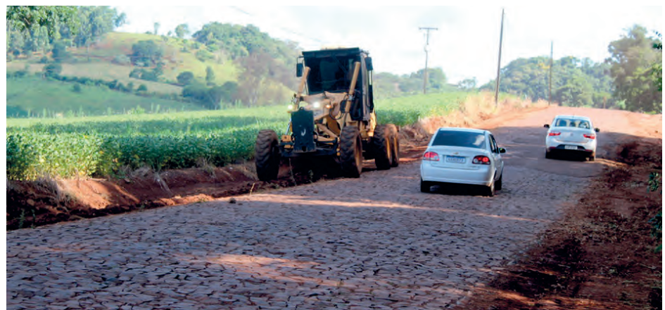
Mais de 16 toneladas de pedra brita serão transportadas pelo local
